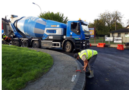
↑ Le giratoire a été doté de nouvelles bordures dont les fondations ont été renforcées pour éviter les retournements.
